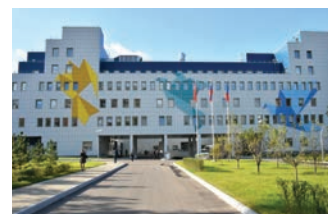
Перинатальный центр, г. Щелково
