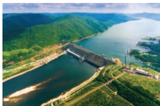
Красноярская ГЭС, г. Дивногорск
