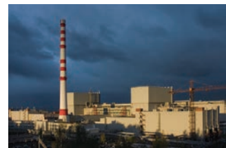
Ленинградская АЭС, г. Сосновый Бор
